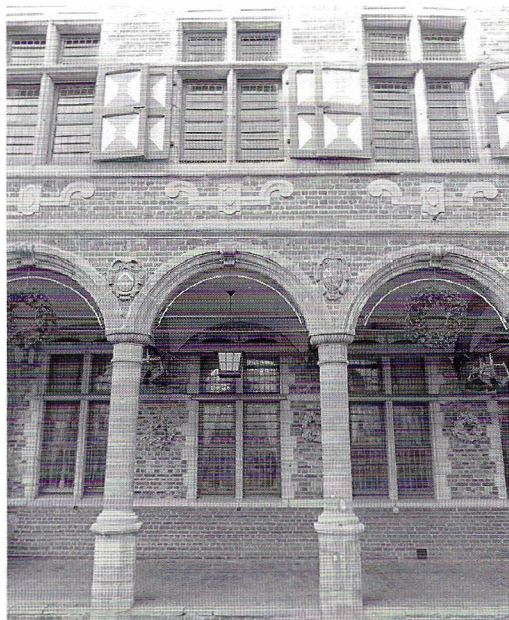
4. Huidige toestand. Detail arcade en eerste verdieping.
